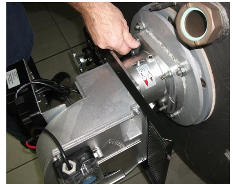
6) Зафиксировать горелки на котел;
