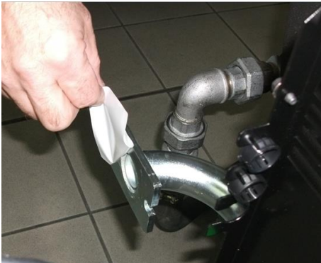
7) Снять заглушку из Труба ГАЗОВОЙ ramпы;
