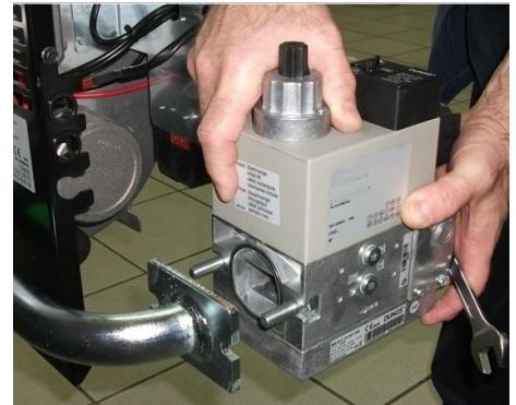
9) установить электроклапан на Труба ГАЗОВОЙ ramпы;
